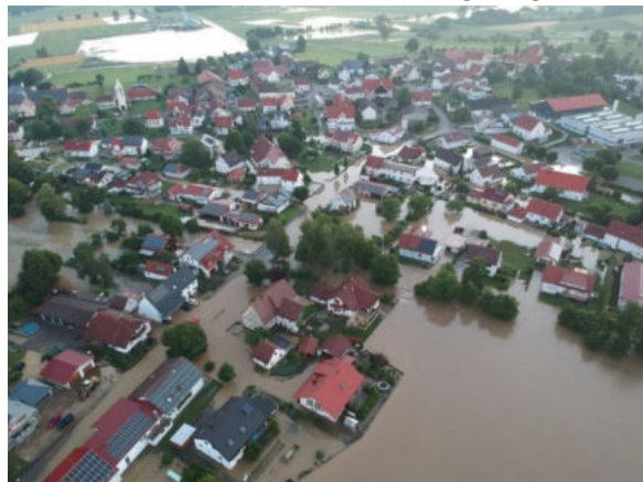
Bild: Luftbild Unterstadion am 24.06.2021, vergleichbar war auch die Ortsdurchfahrt Grundsheim überflutet.
